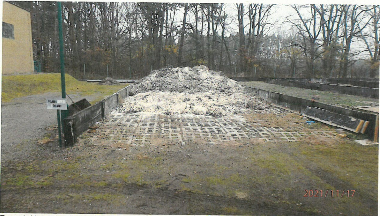
Ryc. 1 Kontrola Zakładu Usług Komunalnych Tworóg Sp. z o.o. ul. Zamkowa 16 42-690 obiekt: oczyszczalnia ścieków w Tworogu, widok na magazynowane odpady o kodzie 19 08 01 (skratki) na poletku znajdującym się na terenie oczyszczalni ścieków w Tworogu
